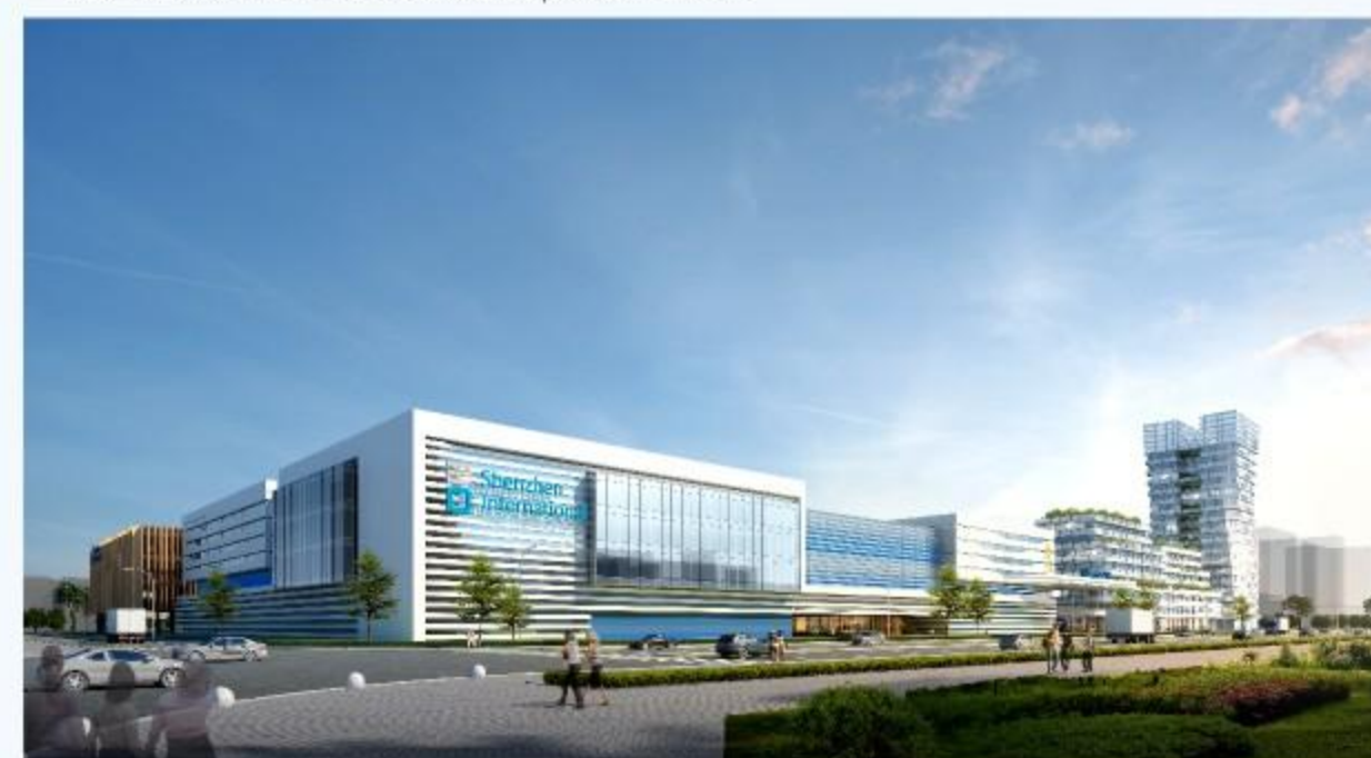
▲ 深国际智慧物流港|深圳·坪山
